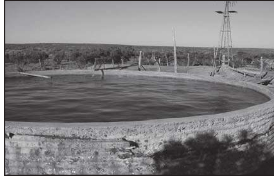
▣ Tanque de agua
