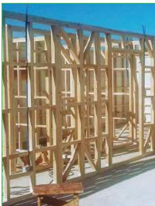
Figura 1: Sistema constructivo de entramado en madera.
