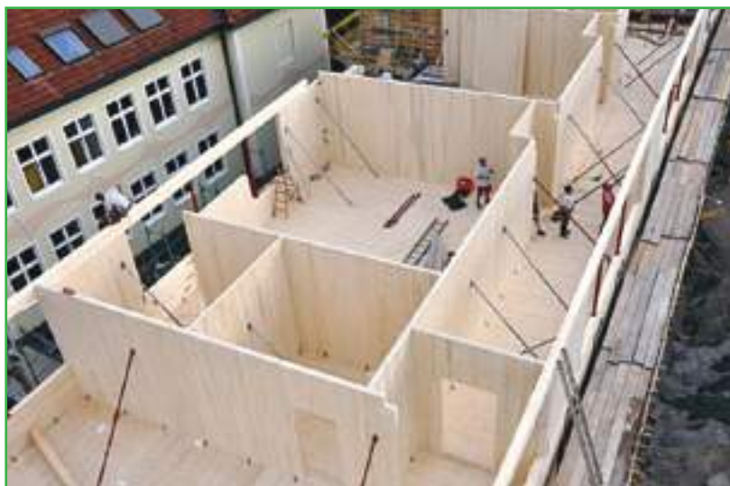
Figura 4: Edificio en proceso de construcción con CLT.
