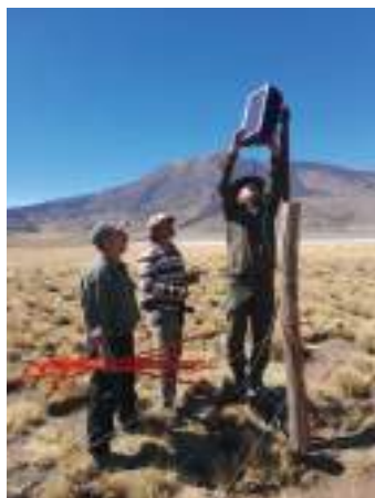
Figura 6: Instalación de equipo electrificador.
