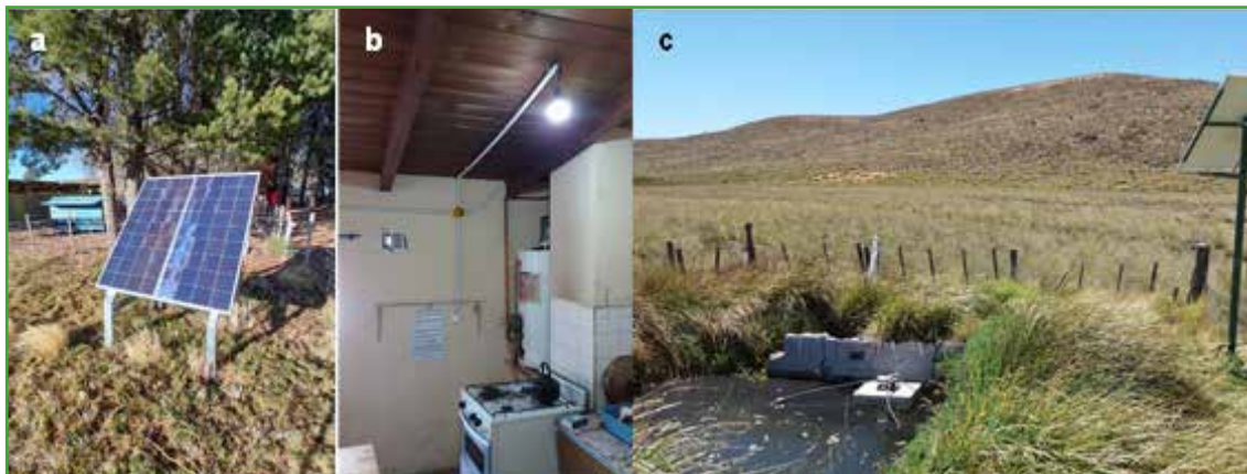
Figura 3: Sistemas de electrificación solar. (a) Panel solar destinado para los equipos de comunicación. (b) Instalación de luz en vivienda de Puesto Blanco. (c) Sistema de bombeo de agua con energía solar.
